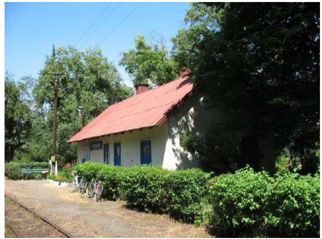
Рис. 10. Станційна будівля Хмільник. Боржавська вузькоколія.
