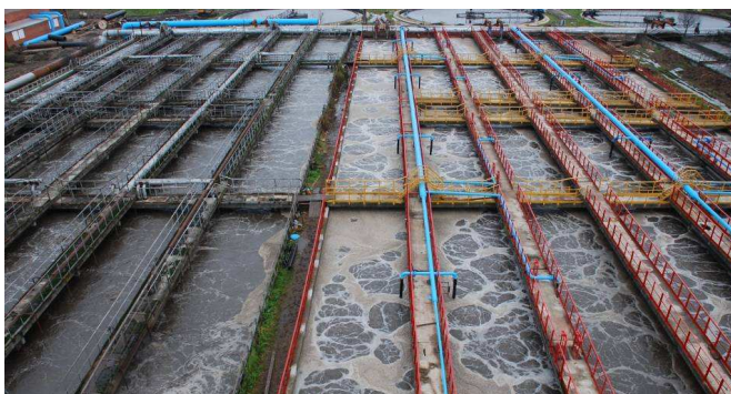
Рис. 4 – Аэротенки до (слева) и после (справа) реконструкции
