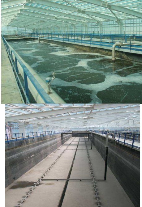
Рис. 5 – Крытые сооружения аэротенков в г. Адлер
