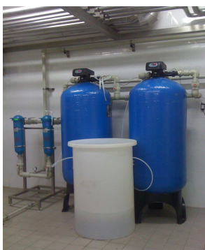
Рис. 4 – Схема блоку доочищення води
