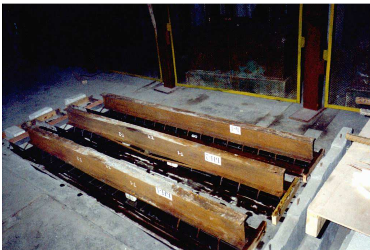
Рис.3 – Установленные в опалубочные формы локально обжатые стальные балки
