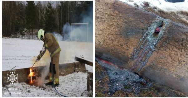
Рис. 7. Робочий момент різання бетонних конструкцій та зовнішній вигляд бетонних конструкцій після роботи апарату
