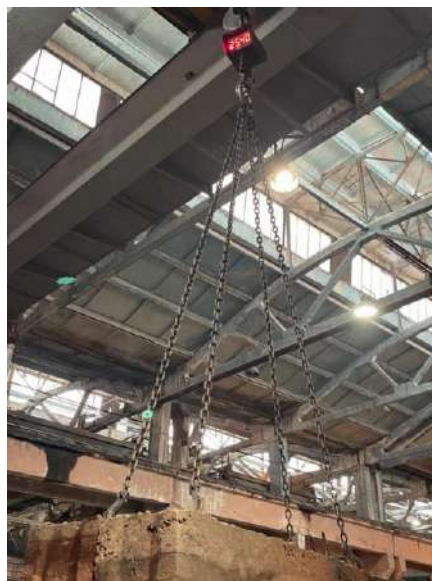
Рис. 2. Попереднє зважування блоків електронними підвісними крановими вагами
