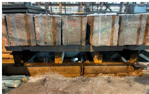
Рис. 3. Завантаження плит блоками ФБС 24-4-6
