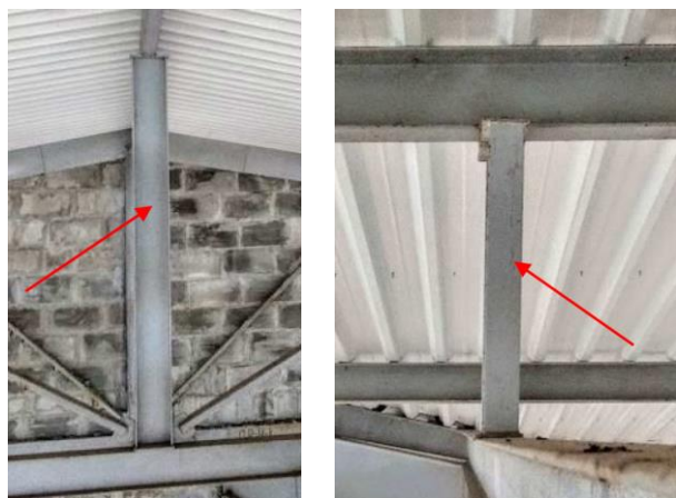
Рис.8 Місця невідповідності проектним рішенням, що встановлені за результатами тахеометричного знімання
