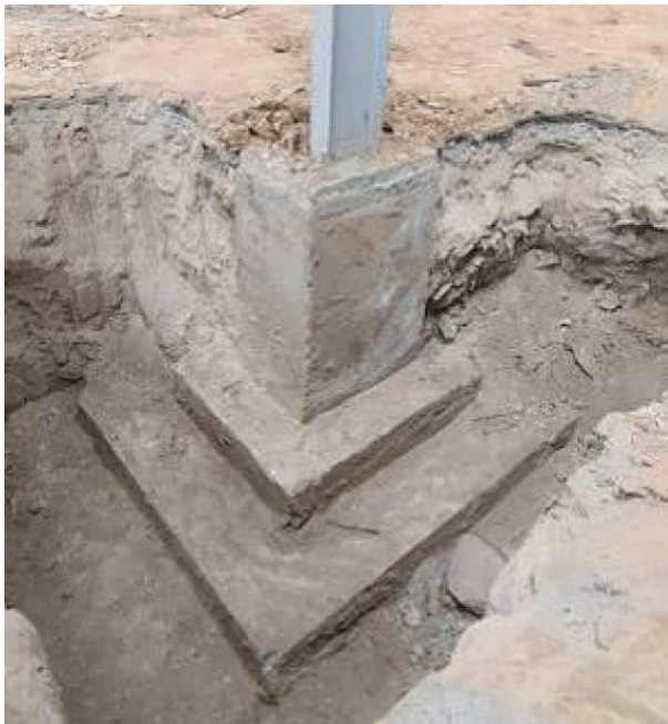
Рис. 5. Загальний вигляд несучих стійок каркасу
