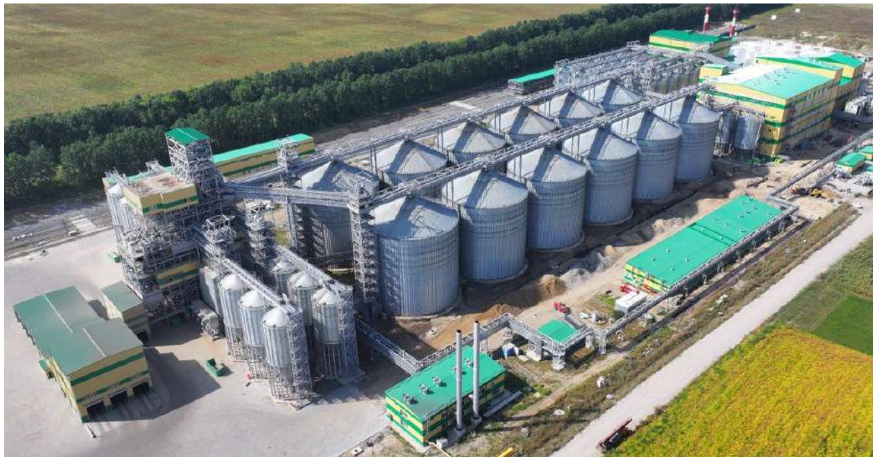
Рис. 1. Загальний вигляд силосів 10.1–10.12 силосного елеватора для зберігання зерна
