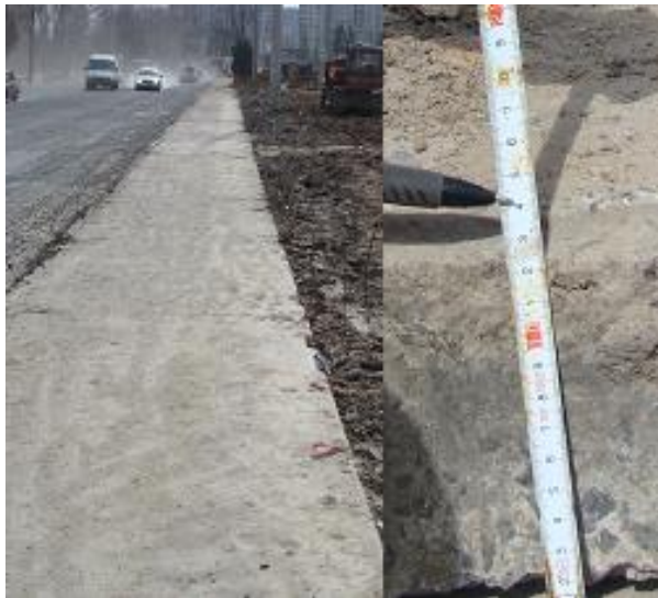
Рис. 1. Загальний вигляд досліджуваної ділянки автомобільної дороги
