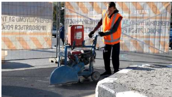
Рис. 5. Прорізання асфальтового покриття дороги
