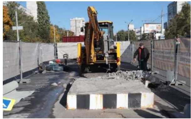
Рис. 6. Демонтаж наявного острівця безпеки екскаватором
