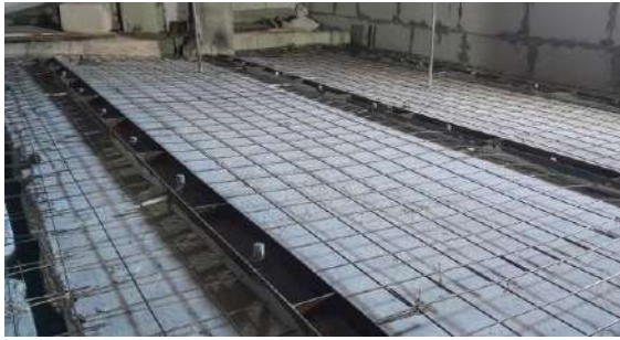
Рис. 11. Виконання плити нарощування
