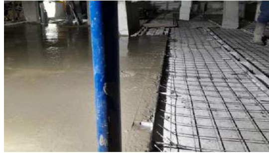
Рис. 11. Виконання плити нарощування
